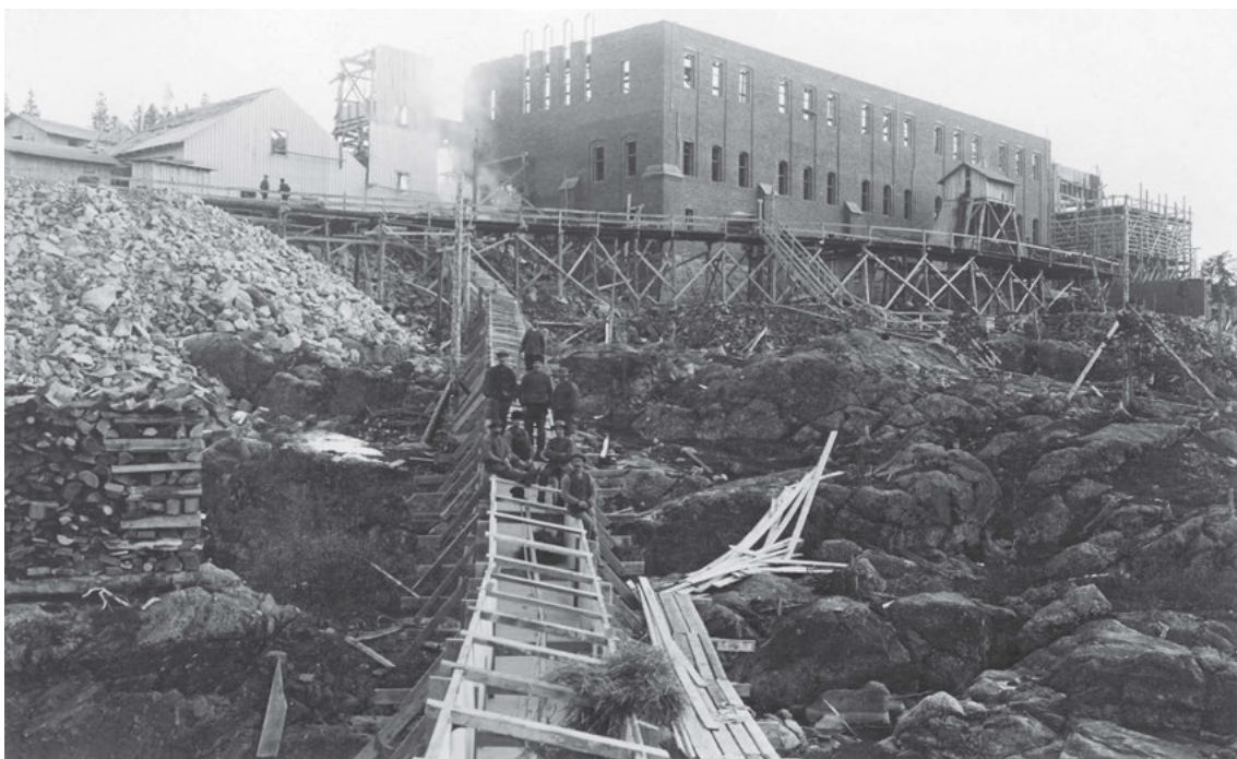
FIGUR 2. Ställverksbyggnaden under uppbyggnad på 1910-talet. Norrbottens museums bildarkiv.
