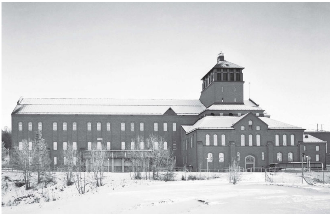
FIGUR 6. Ställverksbyggnaden i Porjus. FOTO: Rolf Kaarlenkaski, Norrbottens museums bildarkiv.
